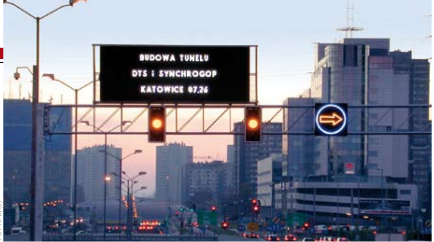
Testowanie tablicy tekstowej VMS, wlot do tunelu inicjowane z centrum sterowania ruchem
